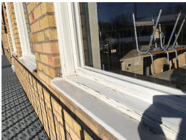
Foto 8. Fönster sydsidan i behov av renovering.
