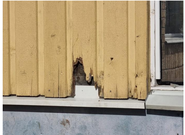
Foto 4. Lokala skador på fasad.
