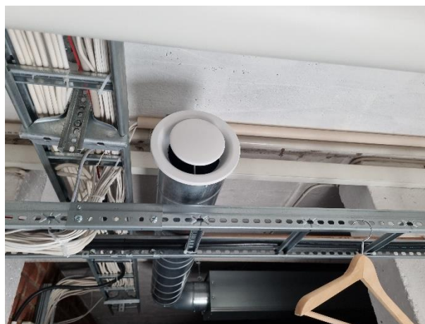
Foto 16. Frånluftsfläkt med dubbla ljuddämpare monterade inne i pannrummet med luften evakuerandes utanför byggnaden.
