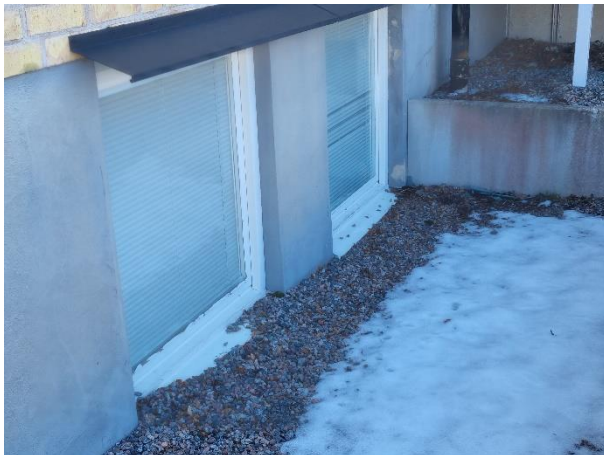
Foto 5. Fönster med marknivå nära bröstning (uk. fönster).
