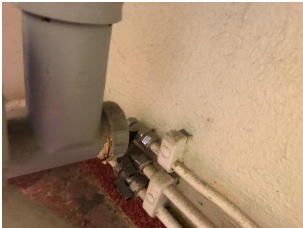
Foto 21. Droppläckage från vattenläs, städ 209
