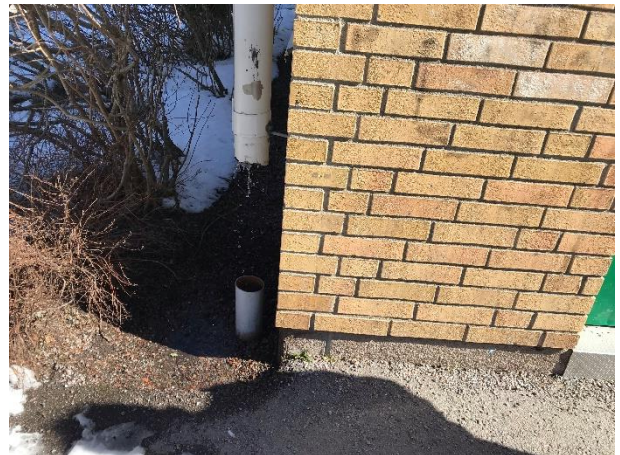
Foto 6. Stuprör med sil saknas lokalt.
