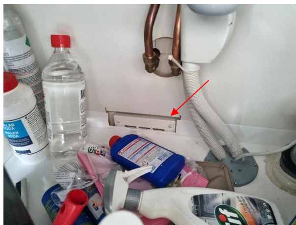
Foto 12. Tilluftsdonets placering kan klart ifrågasättas.
