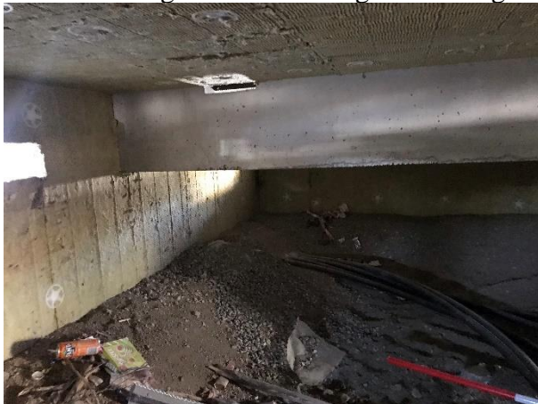
Foto 22. Grund under kök, uteluftventilerad.
