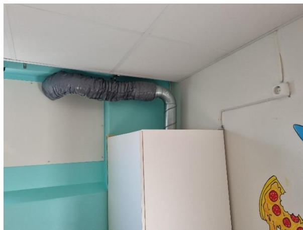
Foto 14. Utförandet på avluftssidan kan klart diskuteras även om funktionen är fullgod.
