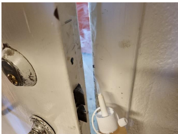
Foto 15. Tydligt undertryck vid röktest inne i pannrummet.
