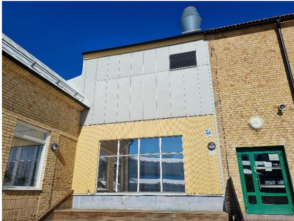
Foto 3. Exempel på fasad med panel.
