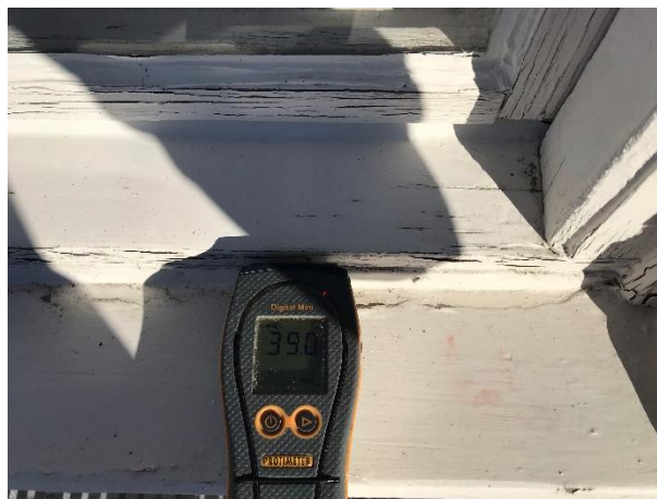
Foto 9. Fuktiga fönsterkarmar på sydsidan.
